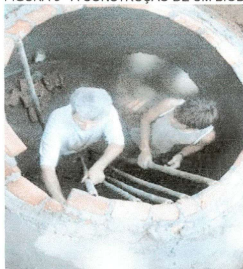
FIGURA 3 - A CONSTRUÇÃO DE UM BIODIGESTOR EM PETRÓPOLIS-RJ
