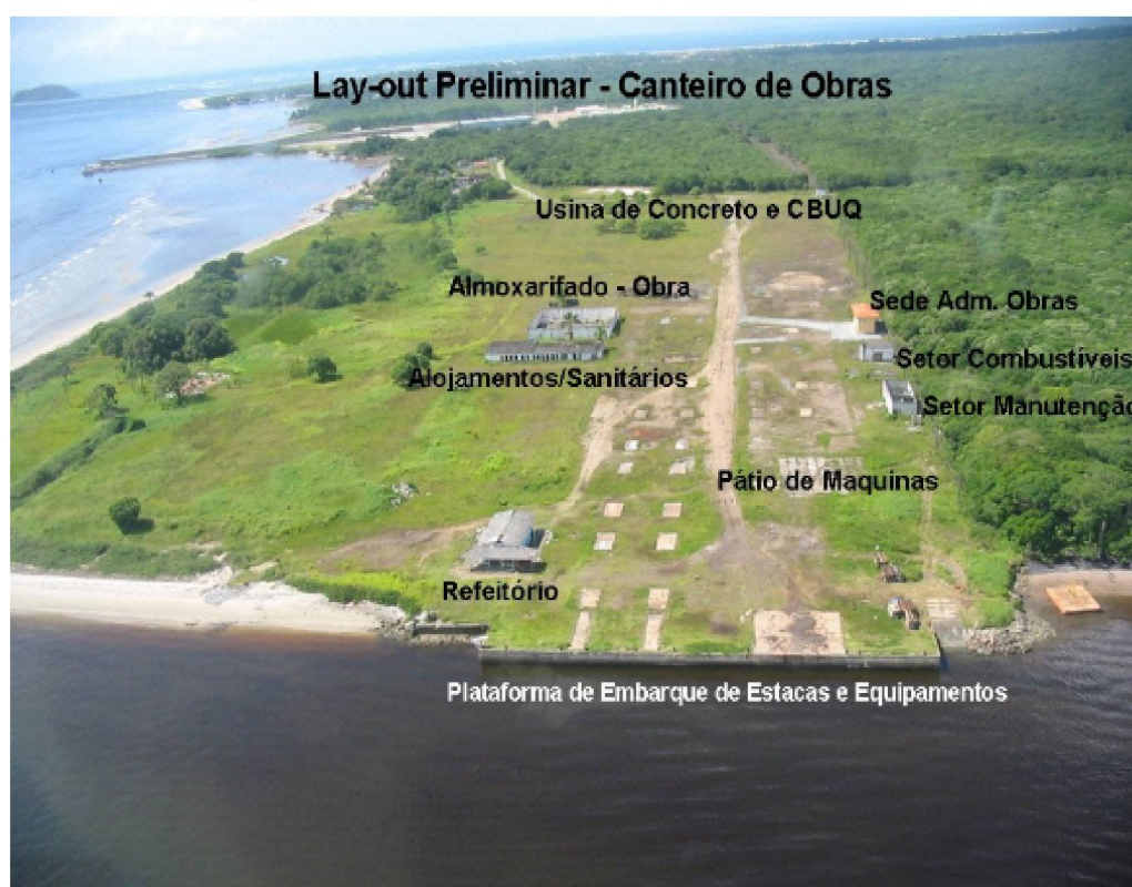
Figura 9: Canteiro de Obras Terminal Portuário em Pontal do Paraná
