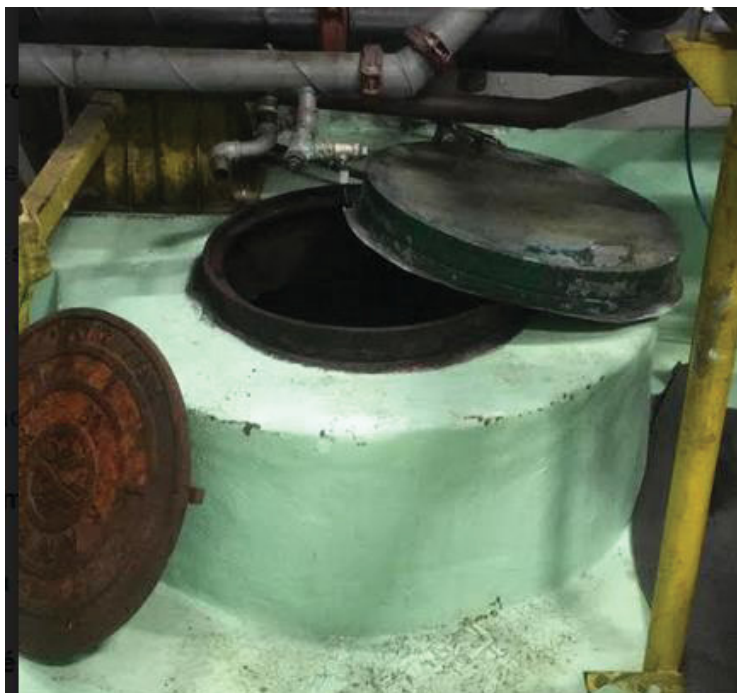
Figura 12 – Fosso de drenagem
