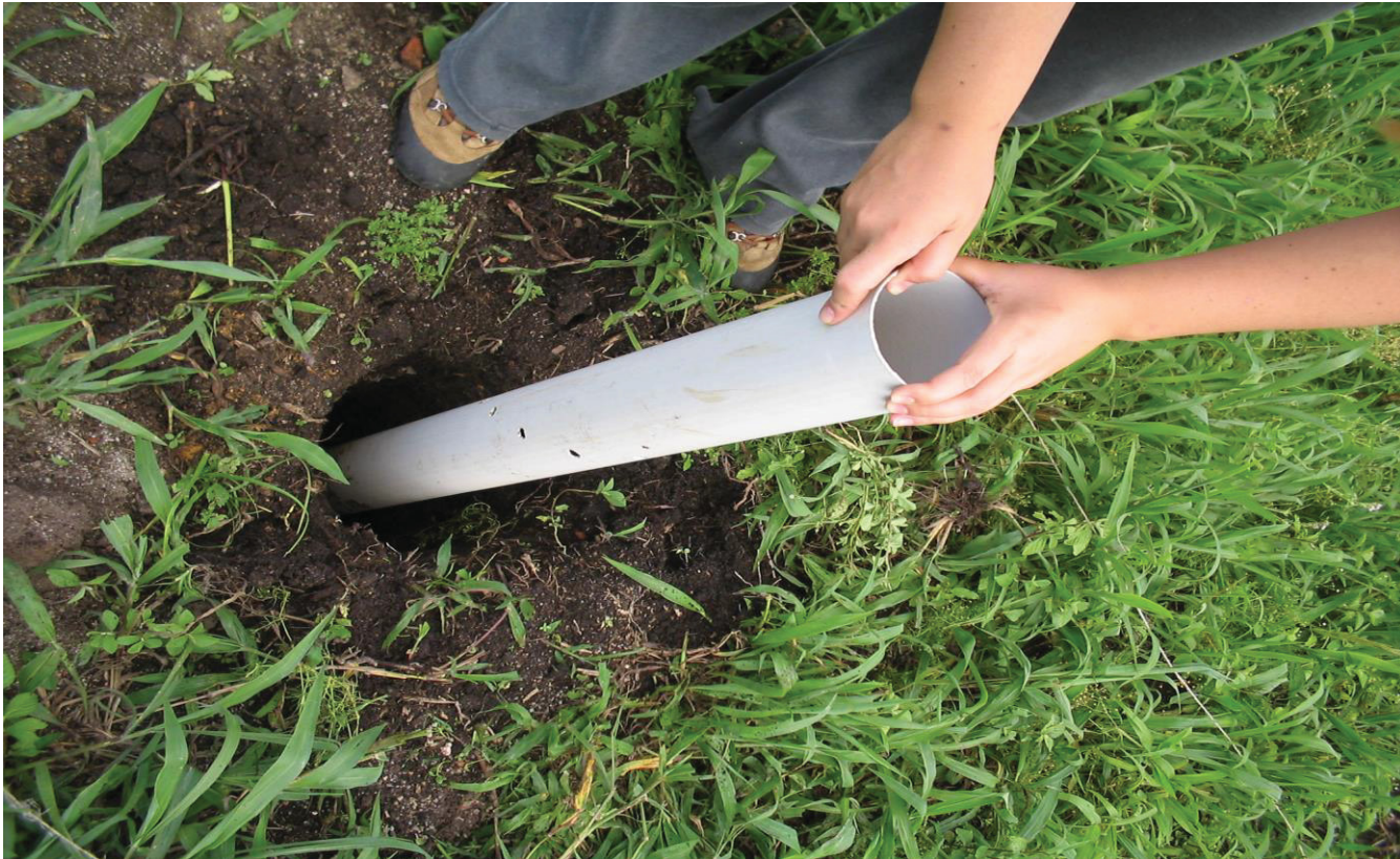
FIGURA 18 - FOTO DA INSTALAÇÃO DO POÇO PISOMÉTRICO
