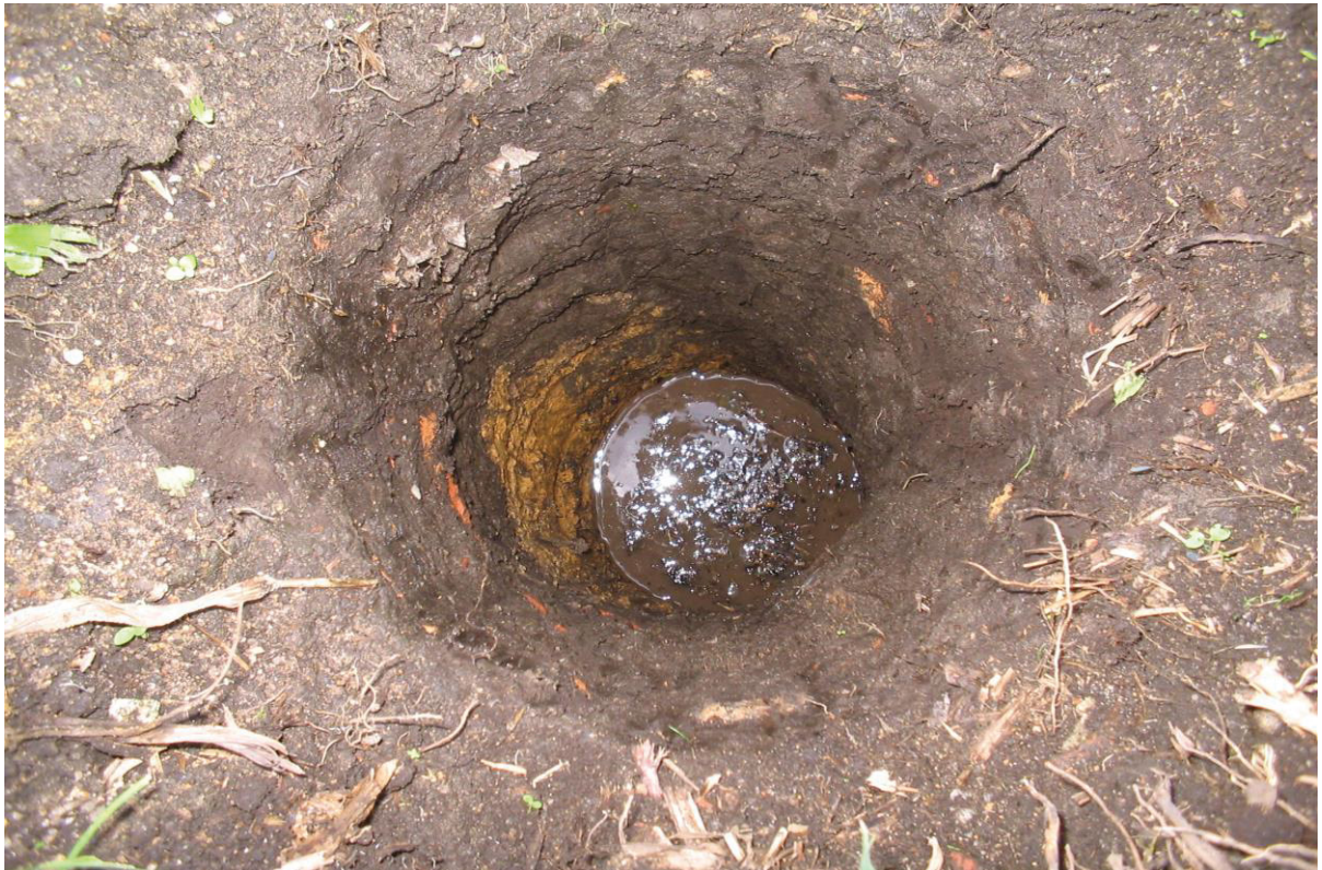
FIGURA 17 – FOTO DO POÇO ABERTO COM TRADO PARA INSTALAÇÃO DO POÇO PISOMÉTRICO
