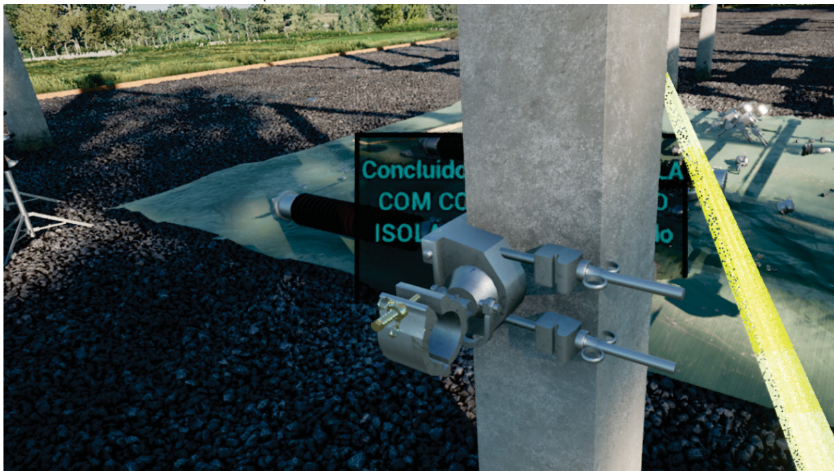
FIGURA 39 – ATIVIDADE 1 (MONTAGEM SELA COM COLAR X PEDESTAL DO ISOLADOR)
