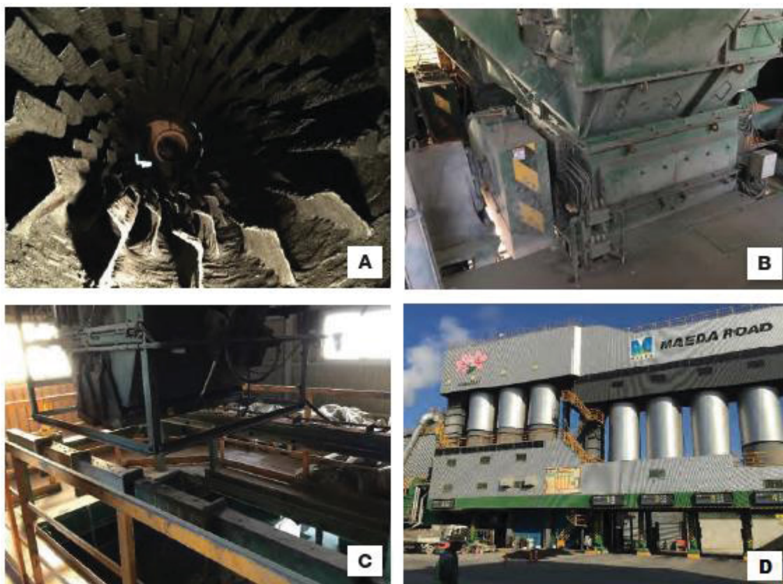
Figura 13 - Usina de asfalto no Japão. (a) Tambor aquecedor e secador para o RAP; (b) Misturador do RAP com o agente rejuvenescedor; (c) Transportador de tremonha para levar o RAP aquecido até os silos de armazenamento e (d) silos de RAP (esquerda) e de misturas a quente (direita).
