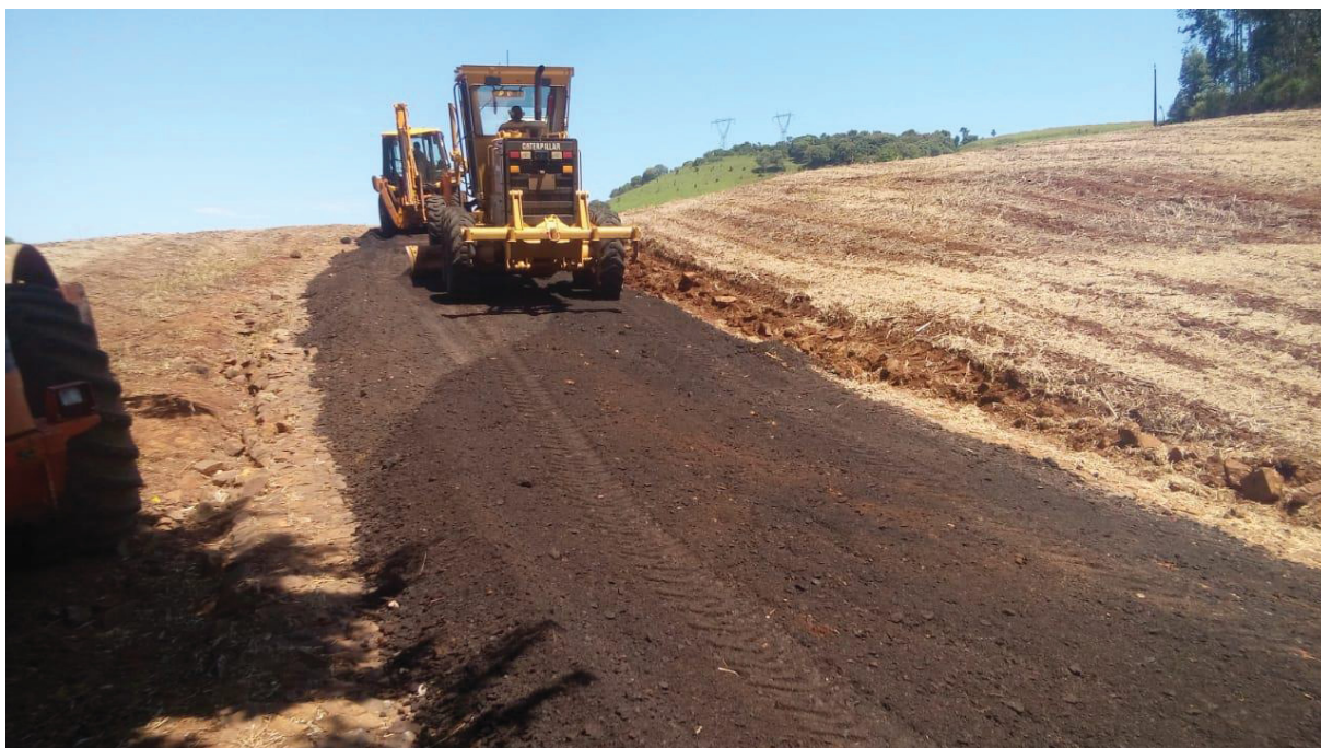
Figura 2 - Aplicação de material fresado em vias de revestimento primário.
