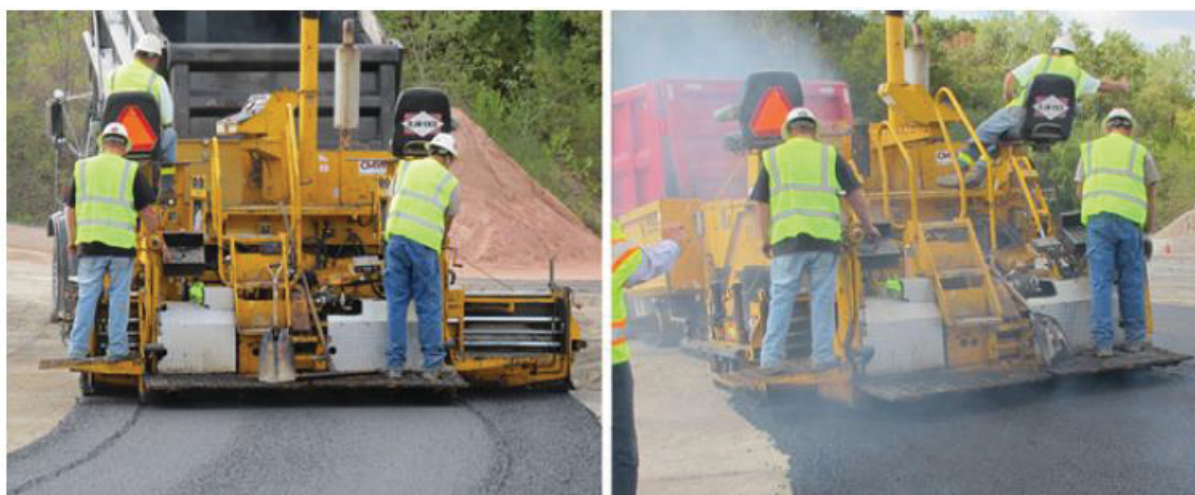
Figura 15 - Pavimentação utilizando técnica de (a) mistura morna e (b) mistura a quente convencional.
