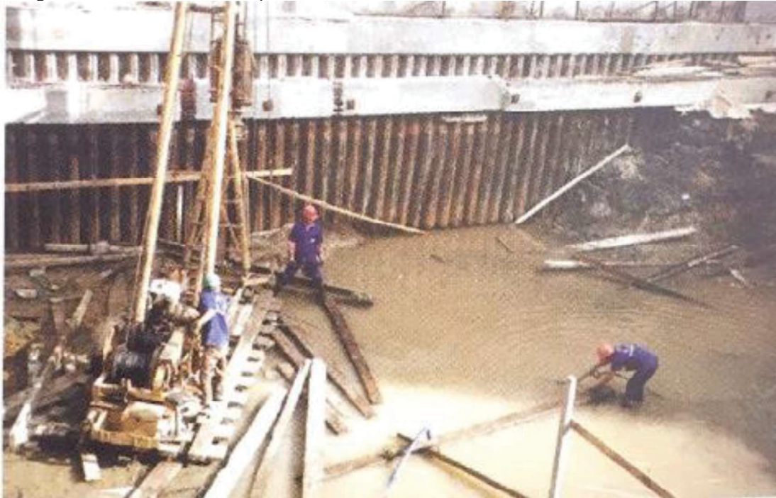
Figura 2-6 - Uso de estacas prancha metálicas em Curitiba - Próximo à reitora da UFPR
