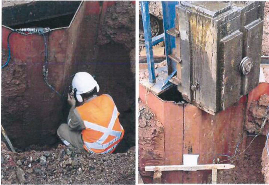
Figura 3-19 - Instalação da instrumentação e execução do ensaio
