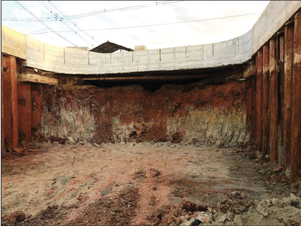
Figura 3-8 - Corte do solo para abertura da trincheira
