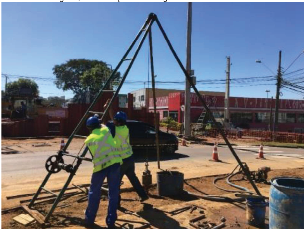
Figura 3-2 - Execução de sondagem SPT durante as obras
