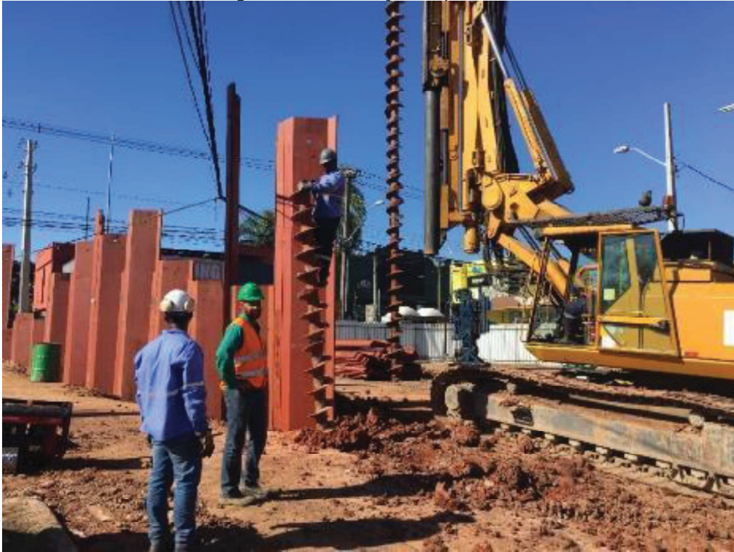
Figura 3-16 - Execução de pré-furos
