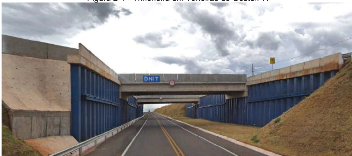
Figura 2-4 - Trincheira em Tuneiras do Oeste/PR
