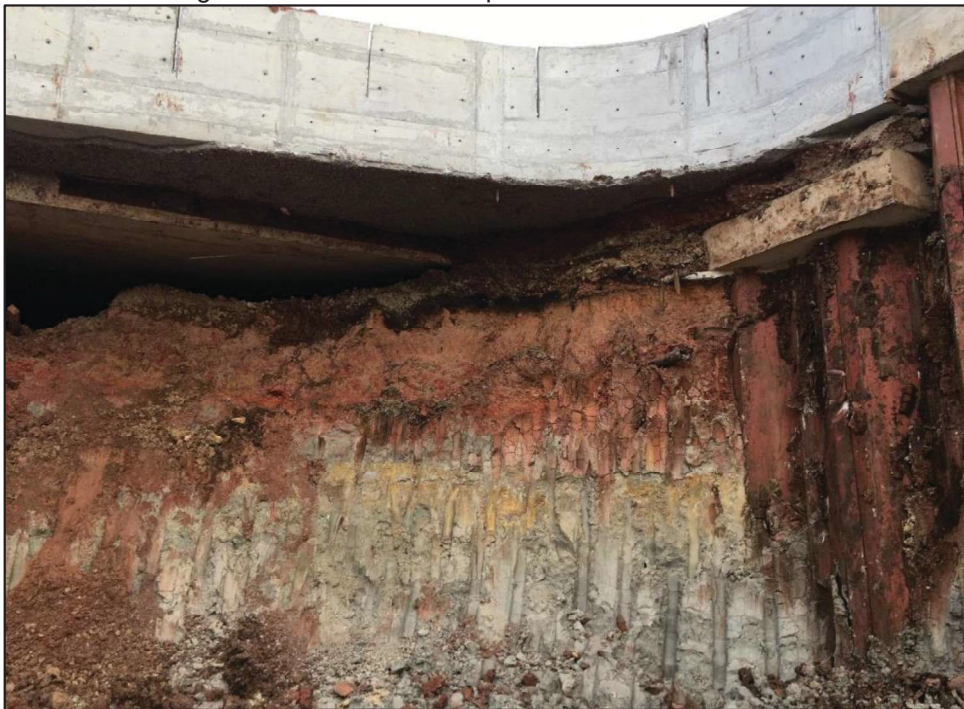
Figura 3-9 - Corte do solo para abertura da trincheira
