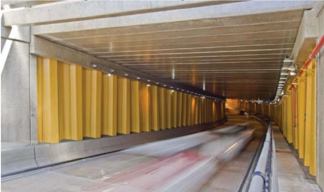
Figura 2-2 - Trincheira Washington Luis Finalizada
