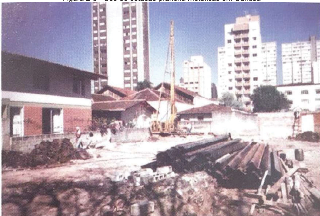
Figura 2-5 - Uso de estacas prancha metálicas em Curitiba
