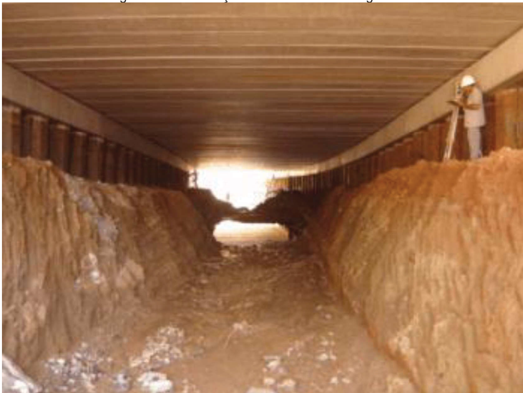
Figura 2-1 - Escavação da trincheira Washington Luis
