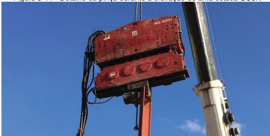
Figura 3-14 - Detalhe da pinça durante a cravação de uma estaca GU8N
