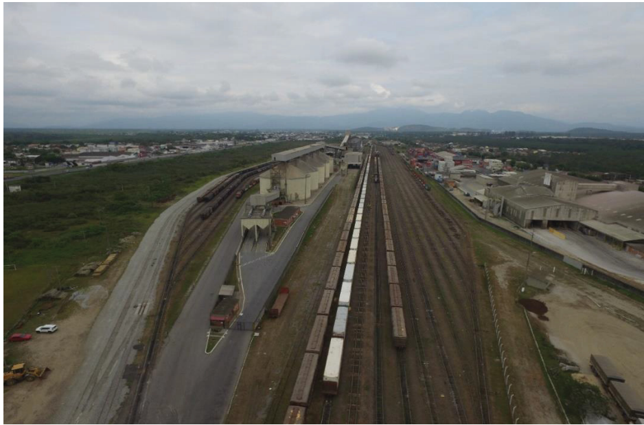
Figura 113 Foto da estação do Km 5
