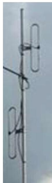
FIGURA 102 – ANTENA MODELO COLINEAR
