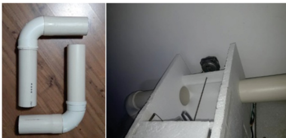
Figura 89 – Instalação dos tubos de condução do ar seco
