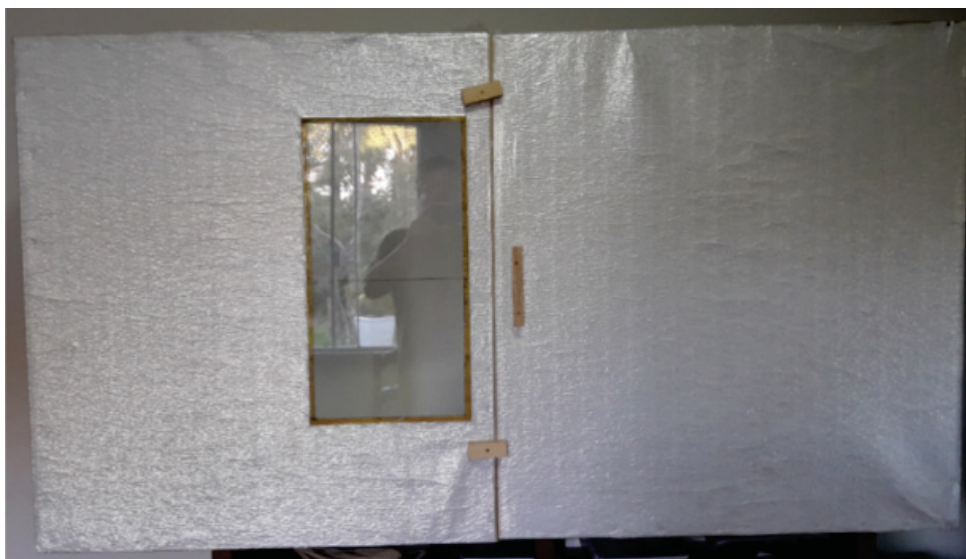
Figura 61 – Forração com a manta térmica concluída
