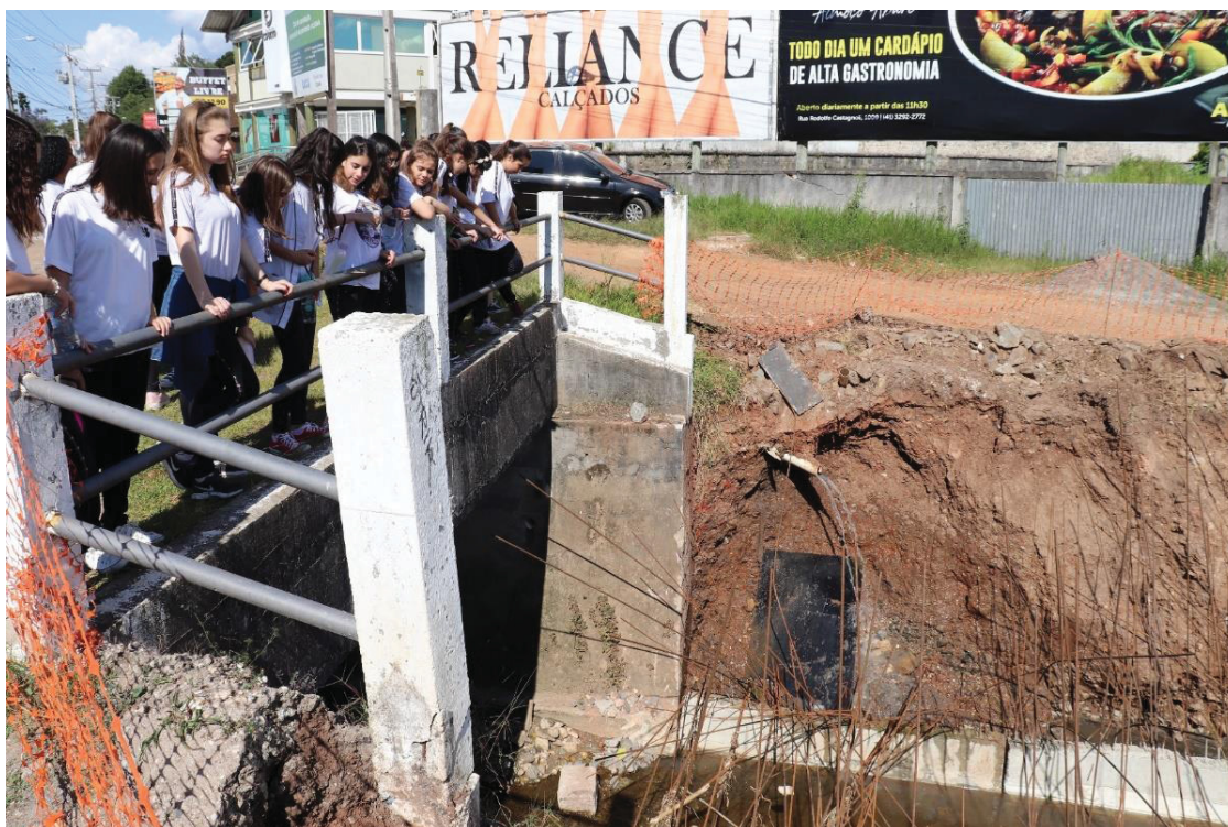
FIGURA 35 – TRECHO DO RIO EM OBRAS – PROCESSO DE CANALIZAÇÃO 01
