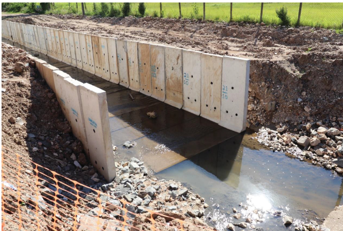
FIGURA 41 – TRECHO DO RIO EM OBRAS – PROCESSO DE CANALIZAÇÃO 03
