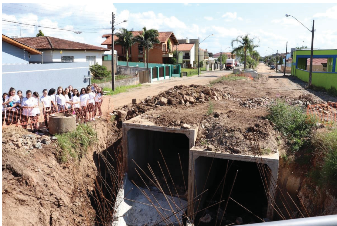
FIGURA 36 – TRECHO DO RIO EM OBRAS – PROCESSO DE CANALIZAÇÃO 02
