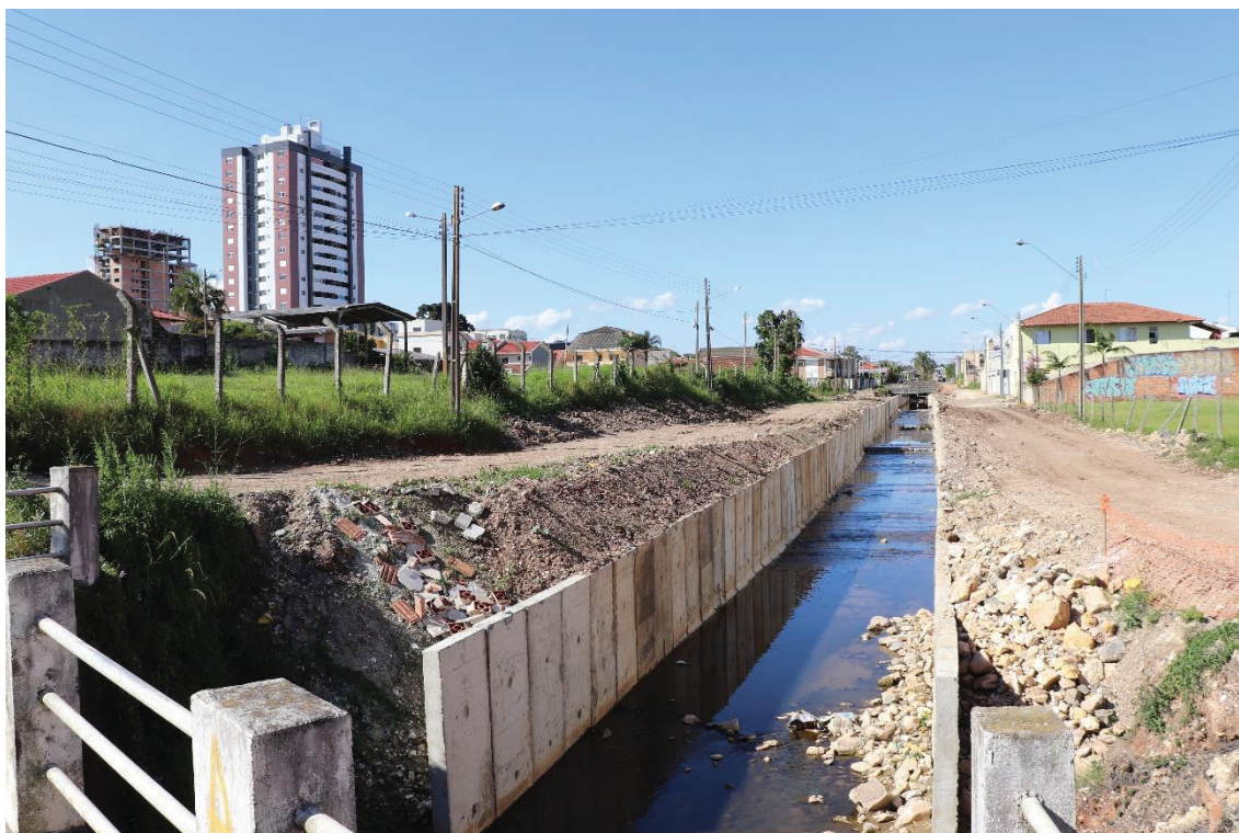
FIGURA 42 – TRECHO DO RIO EM OBRAS – PROCESSO DE CANALIZAÇÃO 04
