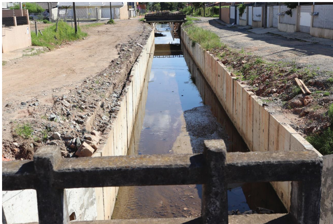
FIGURA 39 – ÁREA CANALIZADA SEM O LEITO NATURAL DO RIO CAMBUÍ
