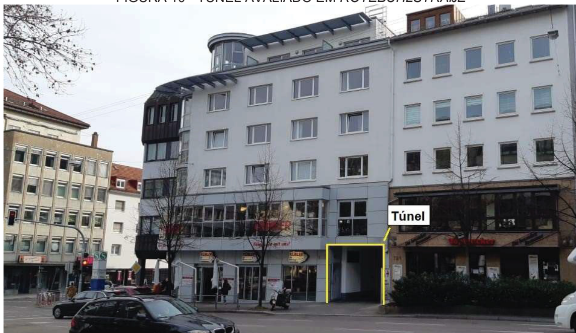
FIGURA 10 - TÚNEL AVALIADO EM ROTEBÜHLSTRAßE
