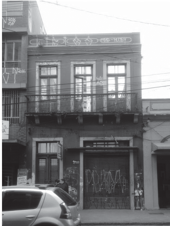
FIGURA 8 - EDIFICAÇÃO NÃO UTILIZADA EM RUÍNAS, SITUADA NA RUA RIACHUELO
