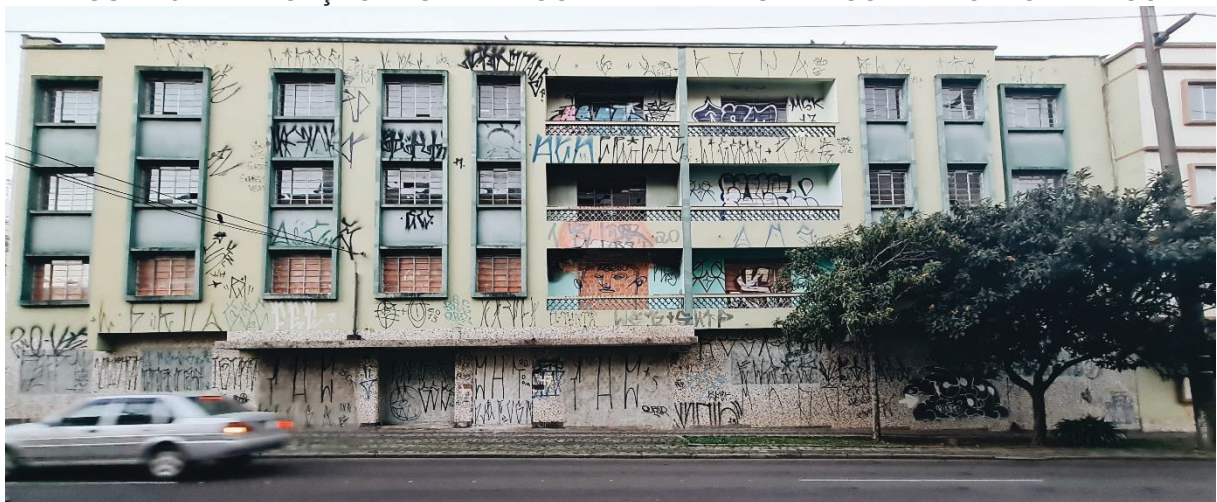
FIGURA 3 – EDIFICAÇÃO LACRADA LOCALIZADA NA RUA VISCONDE DO RIO BRANCO
