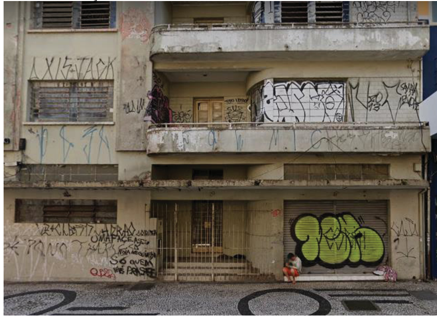
FIGURA 4 – EDIFICAÇÃO LACRADA LOCALIZADA NA RUA CRUZ MACHADO
