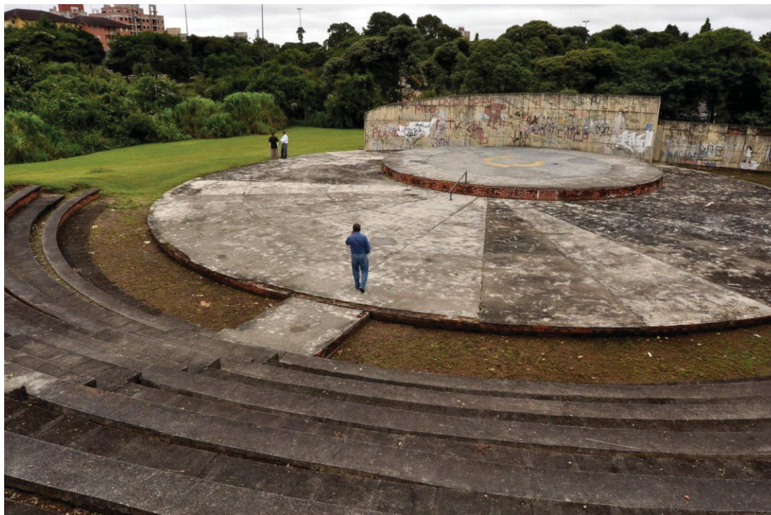
FIGURA 8 – PRAÇA ZUMBI DOS PALMARES ANTES DA REVITALIZAÇÃO – 2010
