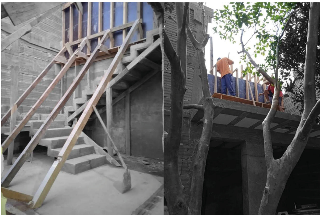
FIGURA 61 – MONTAGEM DO PAINEL SUPERIOR DA FÔRMA DA PAREDE 2
