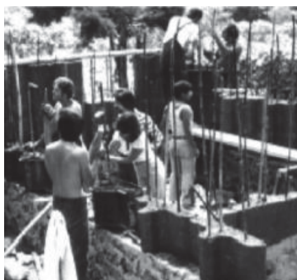
FIGURA 13 – REFORÇO COM BAMBU E MADEIRA
