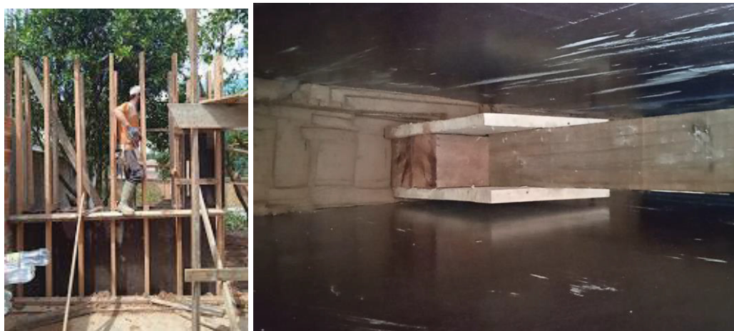
FIGURA 51 – APILOAMENTO – LOCOMOÇÃO DO OPERÁRIO E DENTRO DO TAIPAL
