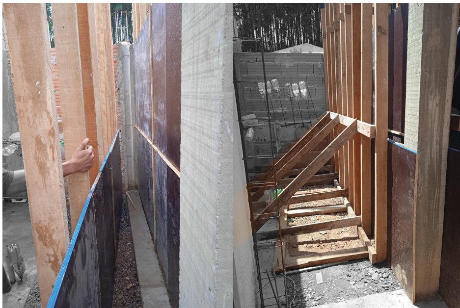
FIGURA 58 – MONTAGEM DO PAINEL TÉRREO DA FÔRMA DA PAREDE 2
