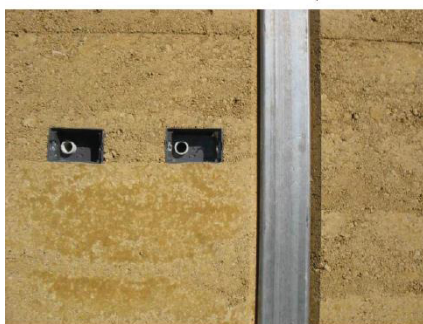
FIGURA 25 – TUBULAÇÃO ELÉTRICA EMBUTIDA
