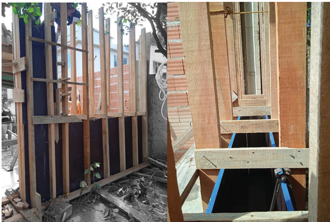
FIGURA 50 – REGISTROS DA MONTAGEM DA FÔRMA DA PAREDE 1
