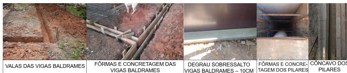
FIGURA 43 – VIGAS BALDRAMES, DEGRAU DE SOBRESSALTO E PILARES
