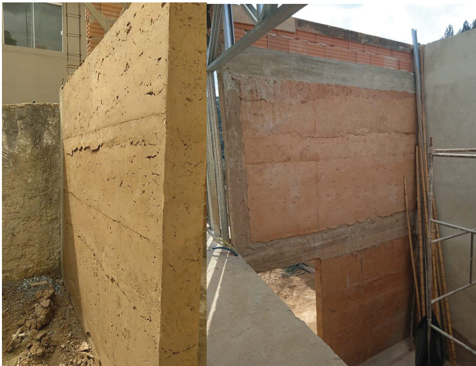
FIGURA 67– DESFORMA DO PAINEL TÉRREO (ESQUERDA) E DO PAINEL SUPERIOR (DIREITA) DA PAREDE 3
