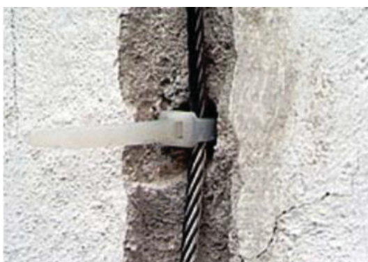
FIGURA 14 – REFORÇO ANTISSÍSMICO
