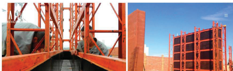
FIGURA 18 – TAIPAIS EM ESTRUTURA METÁLICA – TAIPAL
