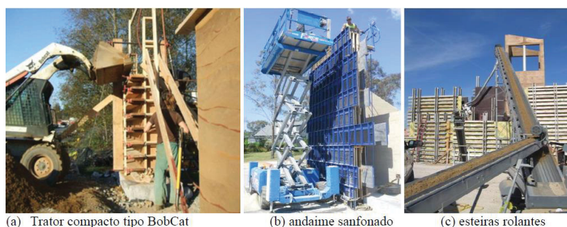
FIGURA 22 – EQUIPAMENTOS PARA TRANSPORTE DO SOLO
