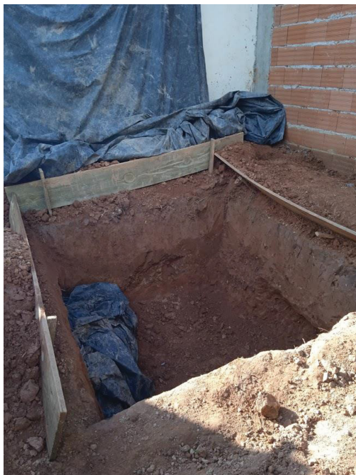
FIGURA 57– BURACO DE RETIRADA DA TERRA PARA A PAREDE 2
