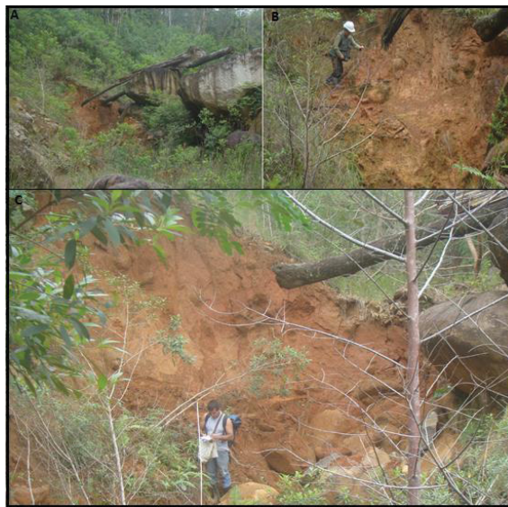
FIGURA 19 - SEÇÃO 03, ÁREA DE MONITORAMENTO DE EROSIÃO E BLOCOS ROCHOSOS (A); PINOS DE MONITORAMENTO DE EROSIÃO (B); REMOBILIZAÇÃO DE SOLO POR MOVIMENTO DE MASSA RASO (C).
