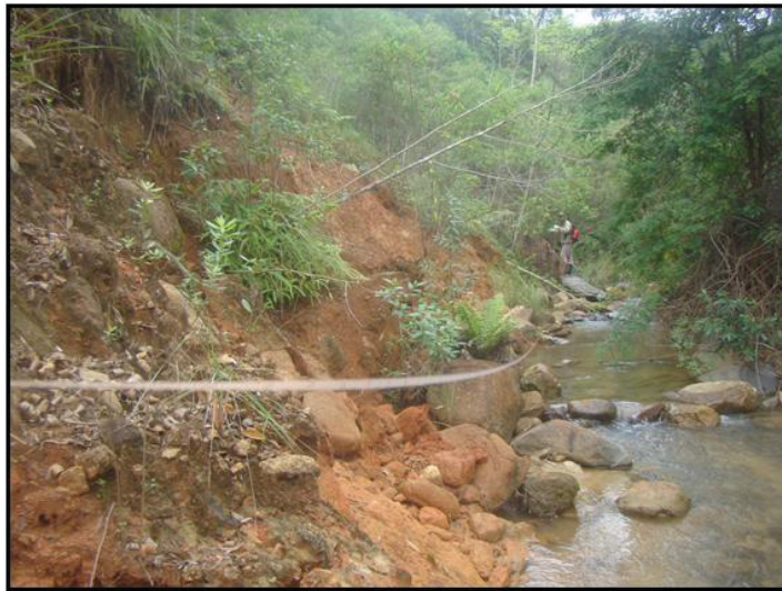
FIGURA 21 - SEÇÃO 04 - ÁREA DE MONITORAMENTO DE EROSÃO E BLOCOS ROCHOSOS APRESENTANDO PEQUENOS MOVIMENTOS DE MASSA
