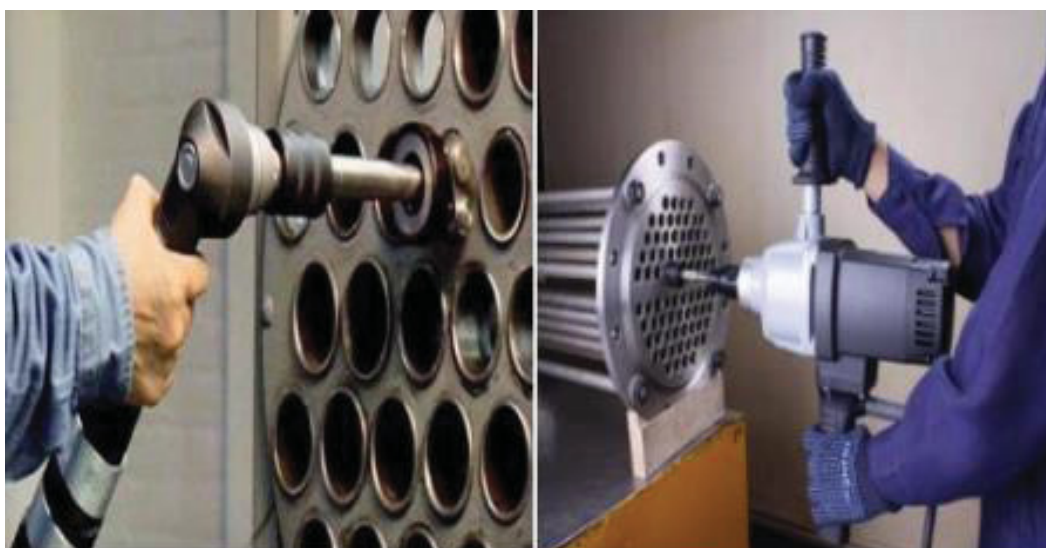
FIGURA 26 – DETALHE DO PROCESSO DE EXPANSÃO DOS TUBO NO ESPELHO
