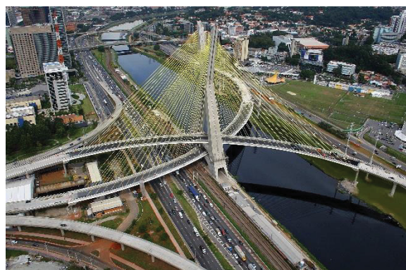
FIGURA 2 – PONTE ESTAIADA OCTÁVIO FRIAS DE OLIVEIRA – SÃO PAULO
