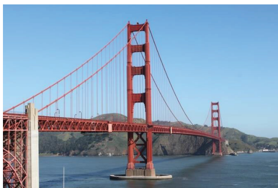
FIGURA 1 – PONTE PÊNSIL GOLDEN GATE – SÃO FRANCISCO
