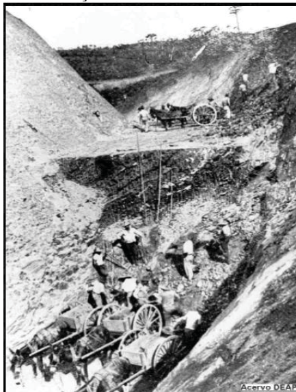
FIGURA 2 – CONSTRUÇÃO MANUAL DA ESTRADA DO CERNE
