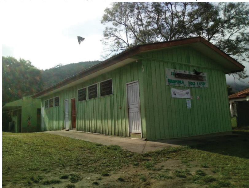
FIGURA 8 – COLÉGIO ESTADUAL QUILOMBOLA DIOGORAMOS, ESTRUTURA PROVISÓRIA.
