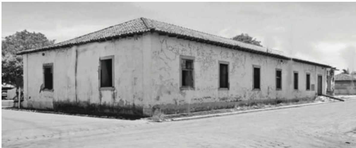
Figura 97 - Palácio dos Capitães Gerais em Vila Bela. 72
