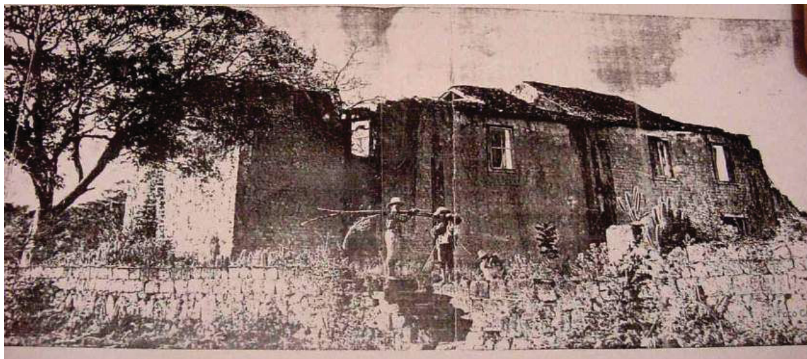
Figura 95 - Registro de algumas das paredes da igreja de Santo Antônio ainda em pé. 70
