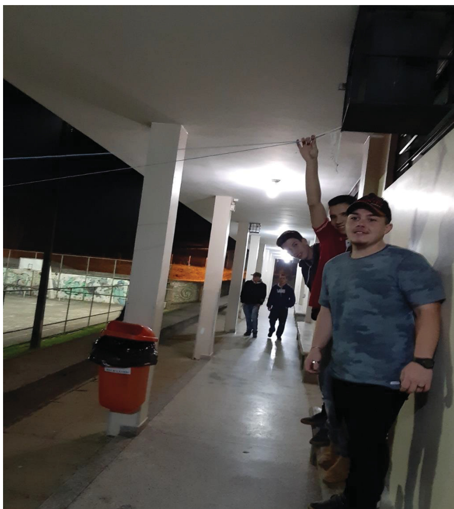
FIGURA 5 – INSTALAÇÃO DA ANTENA EXTERNA REALIZDA PELOS ESTUDANTES
