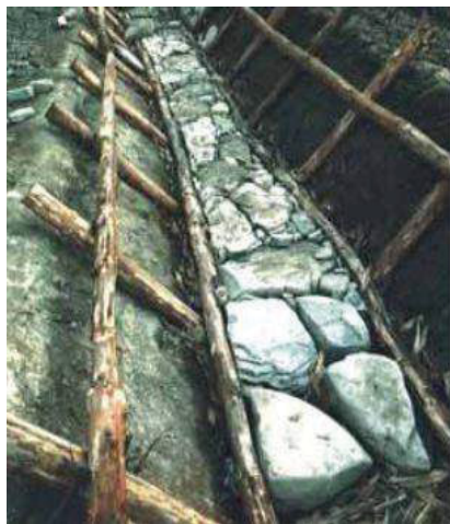
(a) Estabilização com troncos transversais e rochas, com vegetação nas margens
