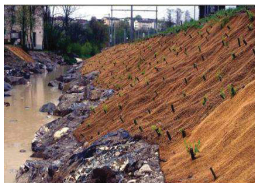
(f) Estabilização com geotêxteis e geomantas vivas
