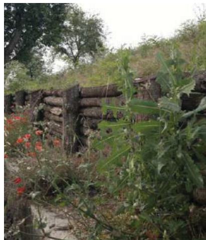
(b) Muro de suporte tipo paliçada viva
