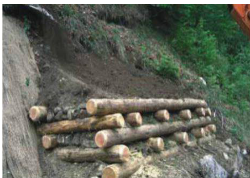
(e) Muro de suporte tipo parede krainer
