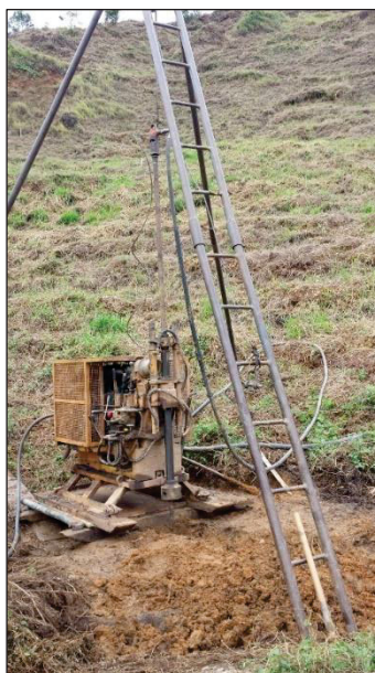
FIGURA 4.9 - PERFURATRIZ MACH 700 UTILIZADA NAS SONDAGENS EXECUTADAS
