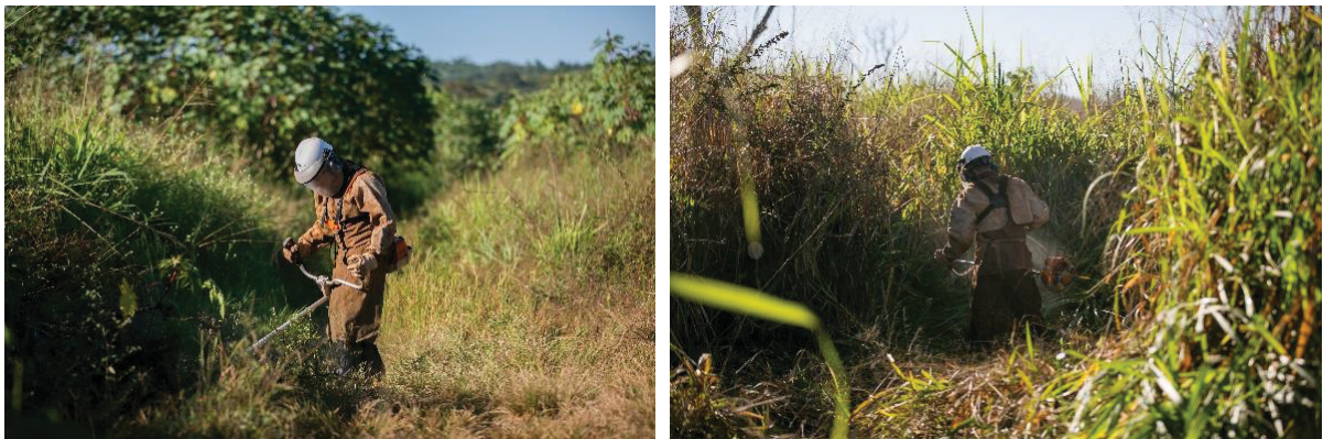
FIGURA 6 - (A) e (B) Uso de Roçadeira na Construção de Aceiros
