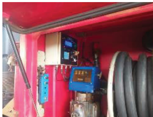
Figura 2b. Caixa de abastecimento instalada no caminhão-comboio
