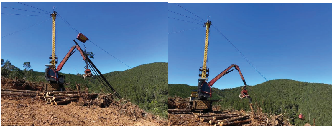
FIGURA 4 – TORRES DO MÓDULO III OPERANDO
