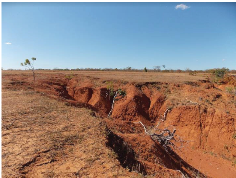
Figura 12. Dimensão da erosão, solo exposto e a vegetação ao fundo. Fonte: Luciano Cavalcante de Jesus França, 2017.
