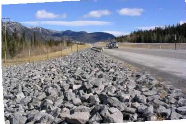
FIGURA 14 - PROTEÇÃO DE BORDA COM MATAÇÃO
