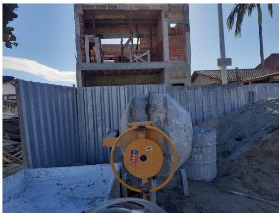
FIGURA 7 – PRIMEIRO EXEMPLO DE OBRA VISITADA DURANTE A PESQUISA DE CAMPO
