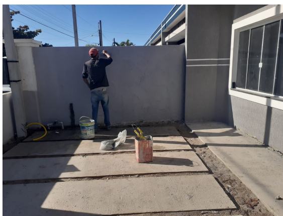
FIGURA 8 – SEGUNDO EXEMPLO DE OBRA VISITADA DURANTE A PESQUISA DE CAMPO
