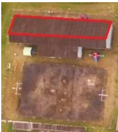
FIGURA 6 - TELHADO DA ESCOLA, COM DESTAQUE EM VERMELHO PARA UMA ÁGUA COM ÁREA DE APROXIMADAMENTE 140 M 2
