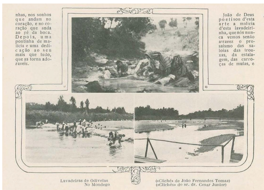
FIGURA 65 – LAVADEIRAS DE ODIVELAS
