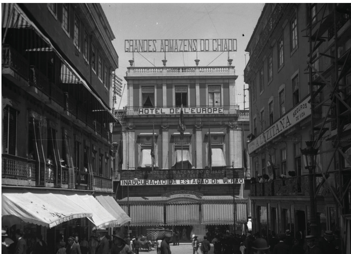
FIGURA 24 – VISTA DOS GRANDES ARMAZÉNS DO CHIADO DESCENDO A RUA GARRETT
