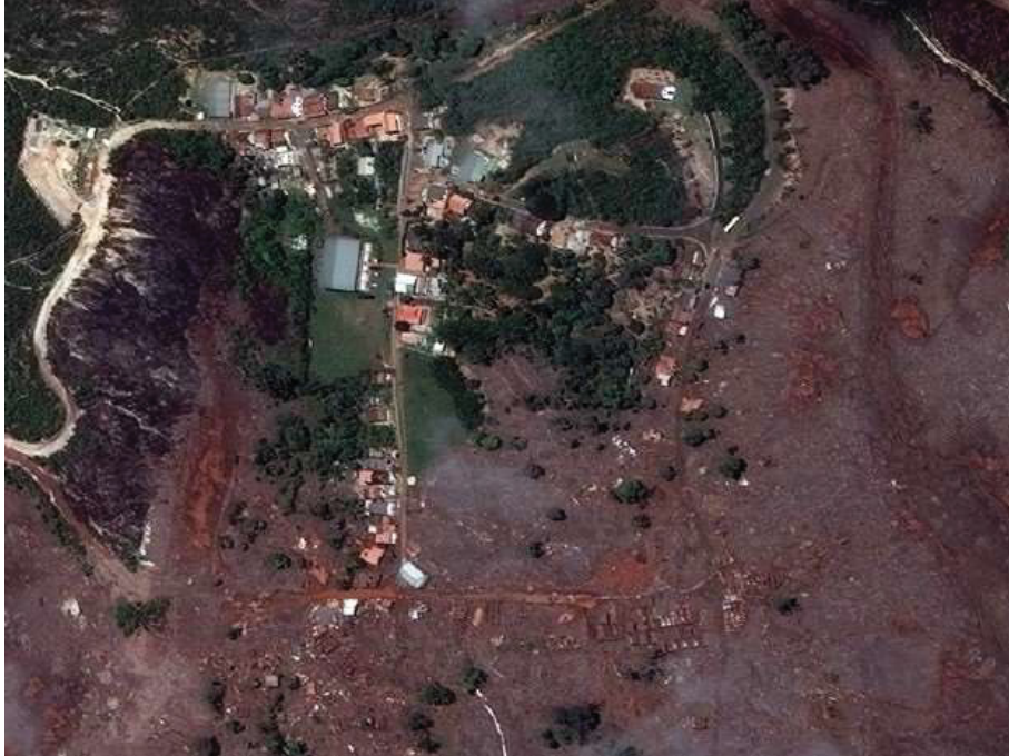
FIGURA 2 - BENTO RODRIGUES APÓS O ROMPIMENTO DA BARRAGEM.
