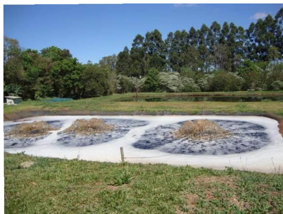
Sistema de tratamento de chorume
