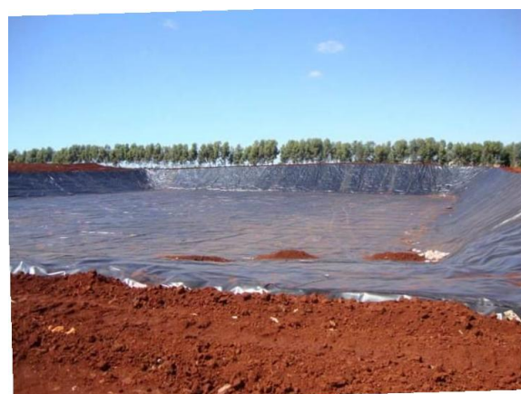
Nova célula em construção
