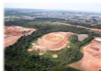
Bacias de contenção
