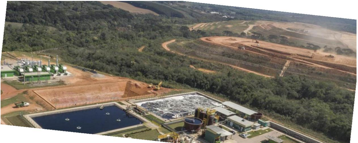
FIGURA 19 - TRATAMENTO DE EFLUENTES DO ATERRO SANITÁRIO DE FAZENDA RIO GRANDE
