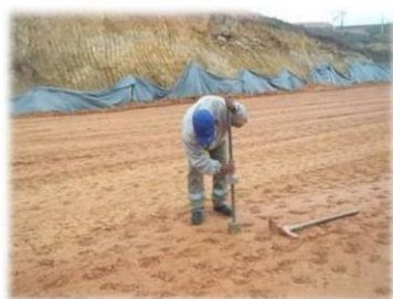
Controle de compactação
