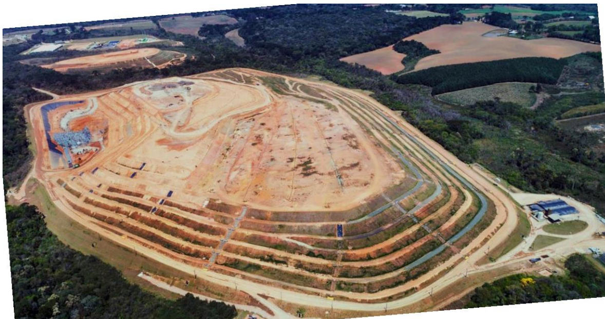
FIGURA 17 - VISTA AÉREA DO MACIÇO ATERRO SANITÁRIO DE FAZENDA RIO GRANDE
