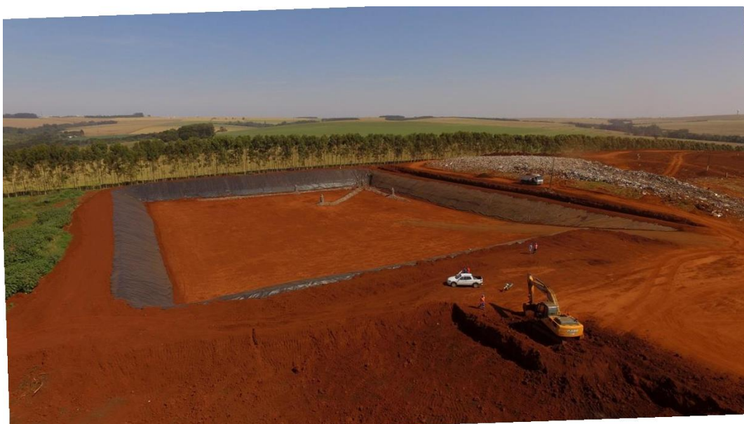
FIGURA 23 - IMPERMEABILIZAÇÃO DE BASE DO ATERRO SANITÁRIO DE CASCAVEL
