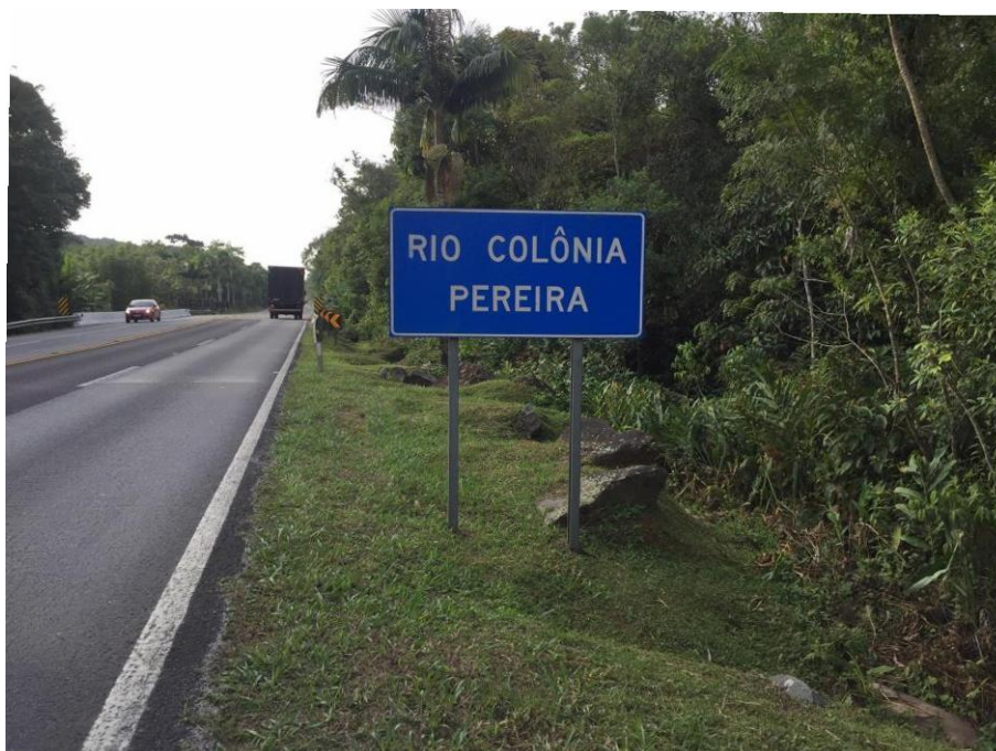
FIGURA 42: PONTE PR-508 X RIO COLÔNIA PEREIRA
