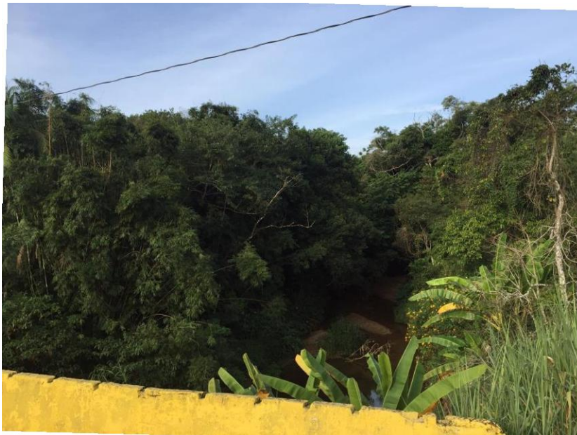
FIGURA 46: PONTE NA ENTRADA DA COLÔNIA PEREIRA
