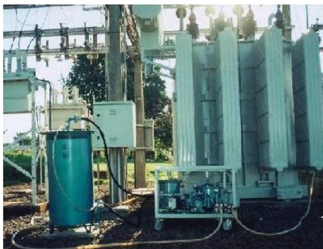
**Figura 5.** Sistema de regeneração “on-line” de OMI em transformador energizado.
