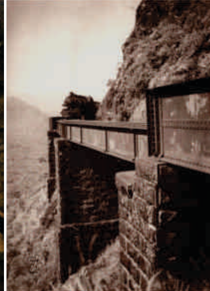
Estrada de Ferro. Viaduto do Carvalho. Fotografia de Armin Henkel
