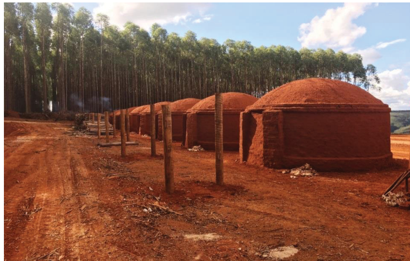
FIGURA 3: ESTÁGIO INICIAL DE CONSTRUÇÃO DA LINHA DE FORNOS, GABARITO E DIMENSIONAMENTO DA PLANTA.
