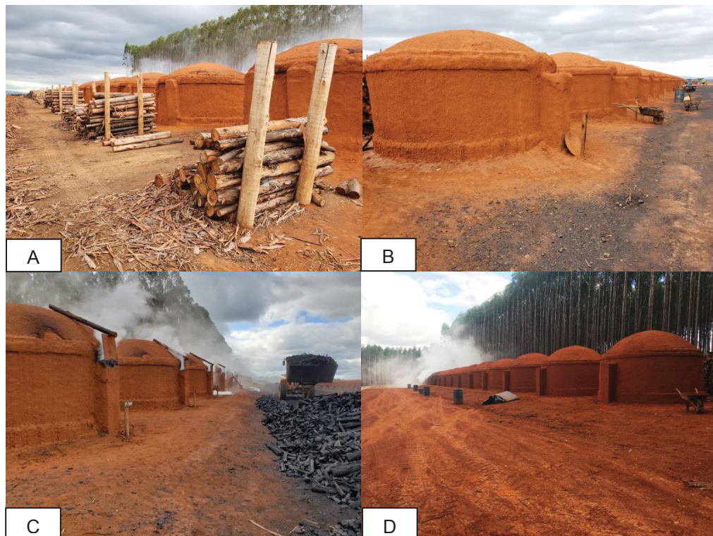
FIGURA 5: ESTRUTURA DA PLANTA DE CARBONIZAÇÃO: A) BOXES DE DEPÓSITO DE LENHA; B) ESTRUTURA DAS CHAMINÉS LATERAIS; C) PROCESSO DE CARBONIZAÇÃO EM ANDAMENTO E ESTOQUE DE CARVÃO NA PRAÇA; D) ESTRUTURA DO ALINHAMENTO DOS FORNOS.
