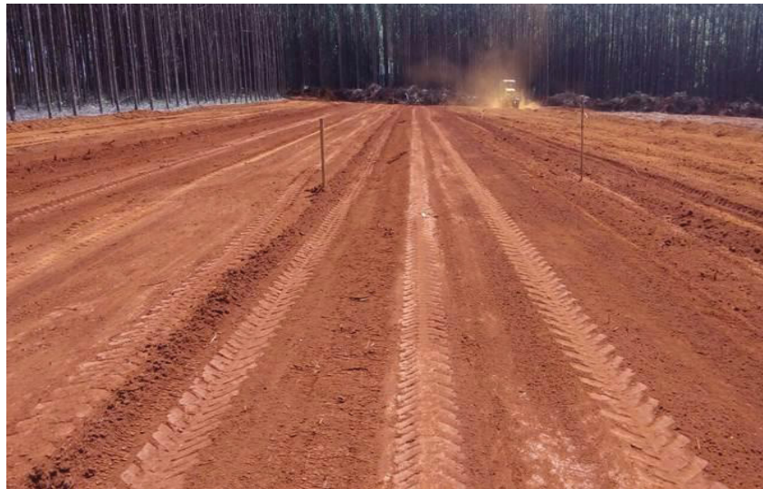
FIGURA 2: TERRAPLANAGEM DA ÁREA DA UPC
