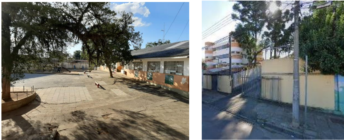
FIGURA 13 – A ESCOLA (FACHADA E PÁTIO EXTERNO)
