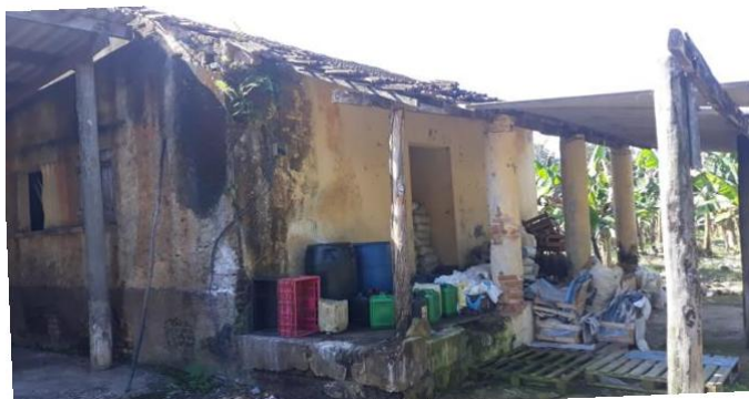
Figura 11 - Antiga base mineradora no bairro Batatal.
