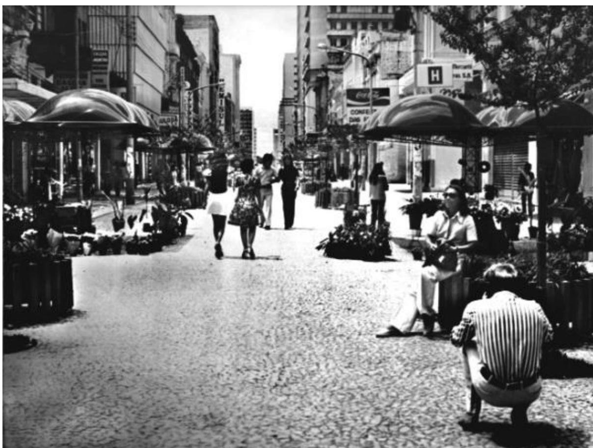
FIGURA 32 - TRECHO DA RUA DAS FLORES, ENTRE A R. MONSENHOR CELSO E A R. BARÃO DO RIO BRANCO, DEPOIS DO CALÇAMENTO EM 1972
