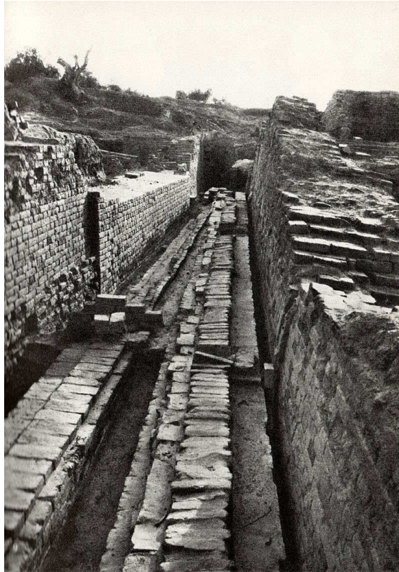
FIGURA 6 - RUA COM DRENAGEM EM MOENJODARO
