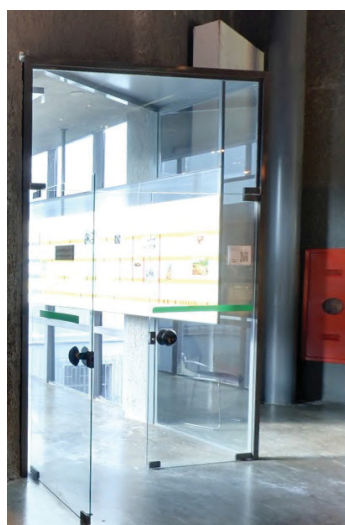
FIGURA 188 — PORTA DE ACESSO AO EDIFÍCIO “ANEXO 2” (PAVIMENTO 1)
