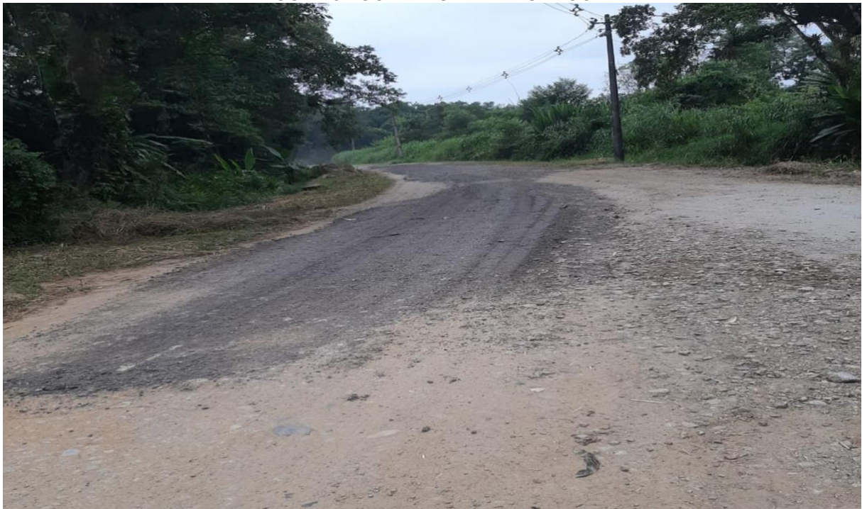
FIGURA 9 –COBERTURA DE BURACOS
