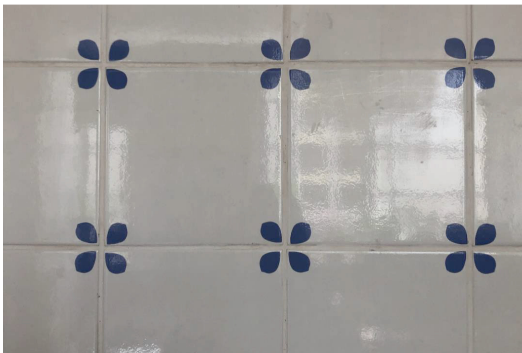
Figura 14. A parede (e os versos) coberta por azulejos.
