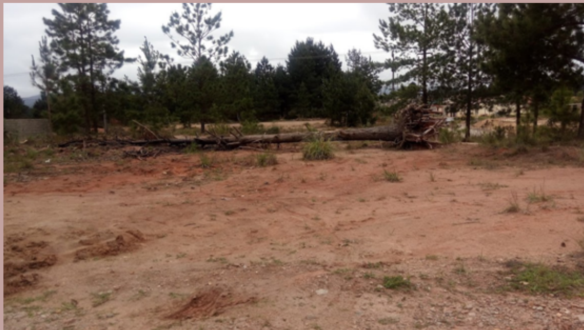
Figura 48: Remoção dos horizontes superficiais do solo para a construção civil na região metropolitana de Curitiba (PR). Foto: Selma Barbosa Bastos
