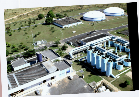
Estação de tratamento de água do Pipiripau Fonte: //bit.ly/33AOCCR
