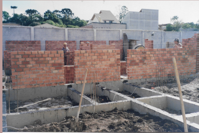
Figura 69: Solo como suporte para construção civil. Foto: Aureo S. T. de Lima
