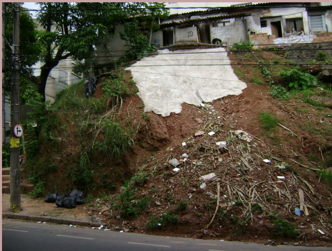
Figura 57: Deslizamento de terra em Belo Horizonte (MG). Fonte: //bit.ly/392Y84F .
