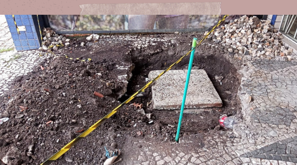
Figura 6: Solo urbano exposto devido a uma obra urbana, em Curitiba (PR). Foto: Selma Barbosa Bastos
