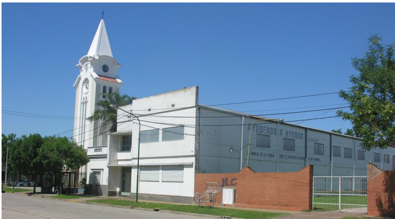
Paróquia do bairro Villa Rosas. Fonte: Acervo próprio.
