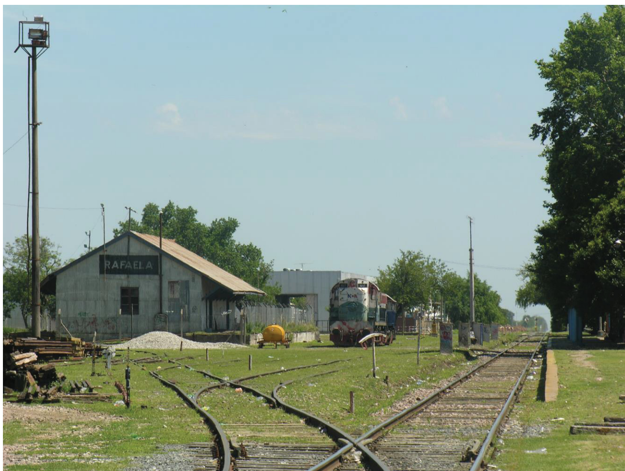
Foto da linha férrea. Bairro Sarmiento, próxima à escola JDP. Fonte: Acervo próprio.
