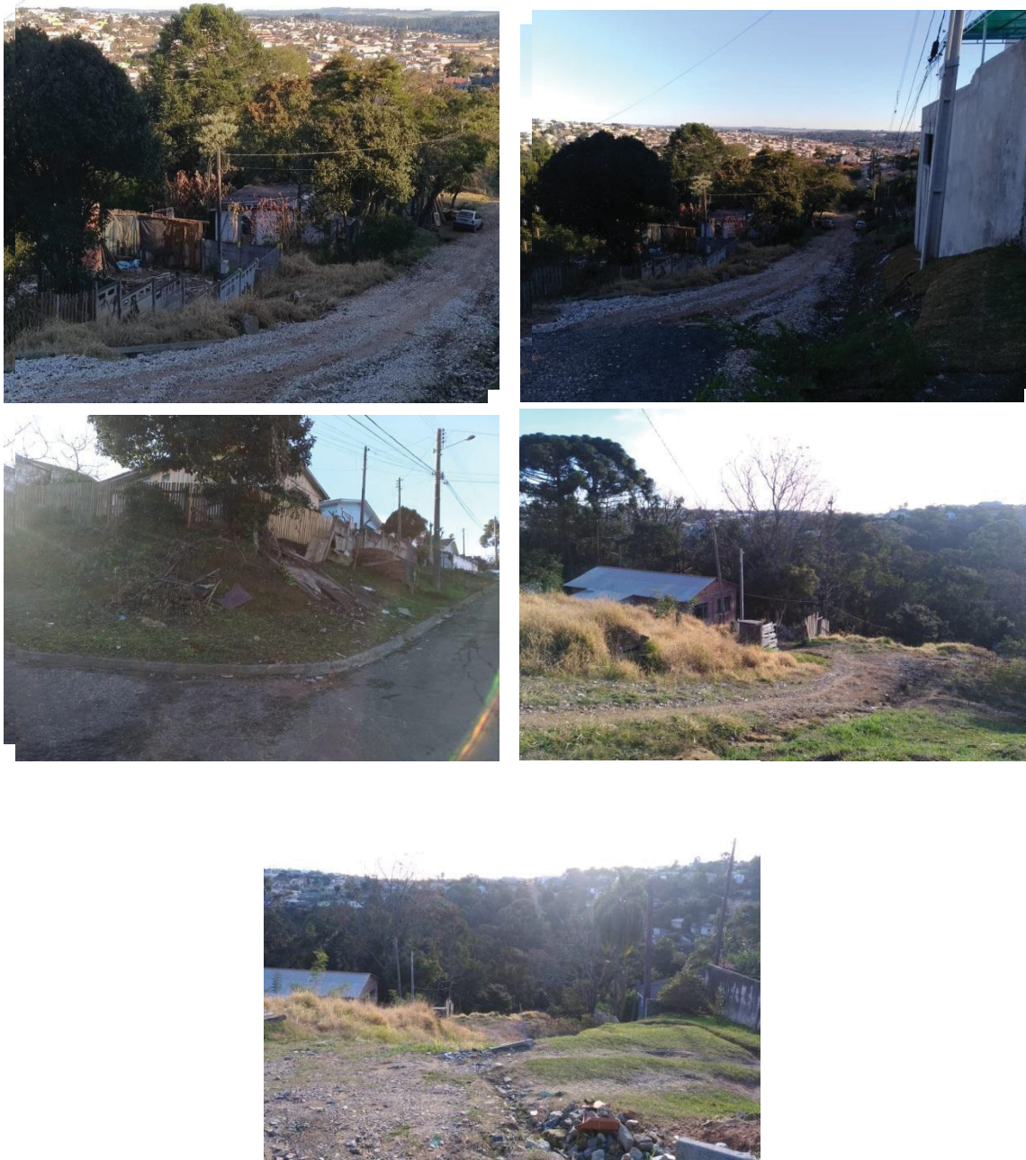
Figuras 10, 11, 12, 13 e 14 - Moradias condições precárias no bairro Nova Rússia, Ponta Grossa – PR.
