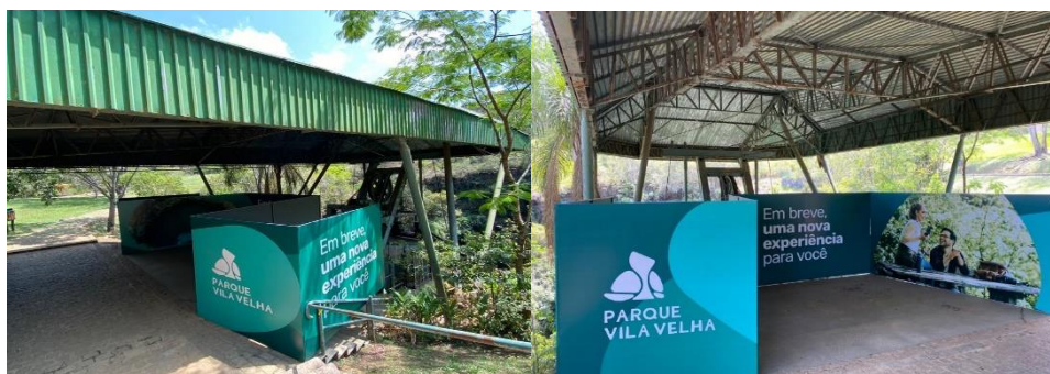
FIGURA 15 - ELEVADOR DE FURNAS
