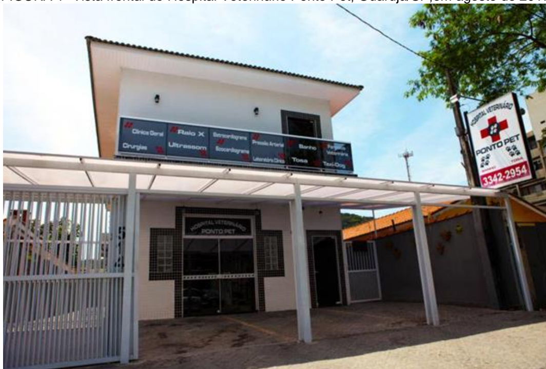
FIGURA 1- Vista frontal do Hospital Veterinário Ponto Pet, Guarujá/SP, em agosto de 2017.
