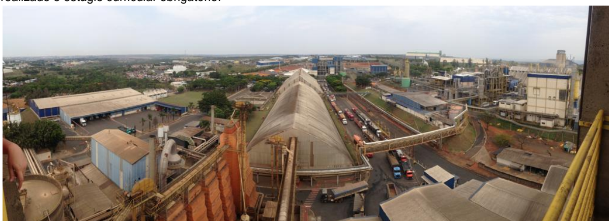
Figura 03: Foto panorâmica parcial de CARGILL AGRÍCOLA S/A – Unidade de Uberlândia/MG. Empresa onde foi realizado o estágio curricular obrigatório.
