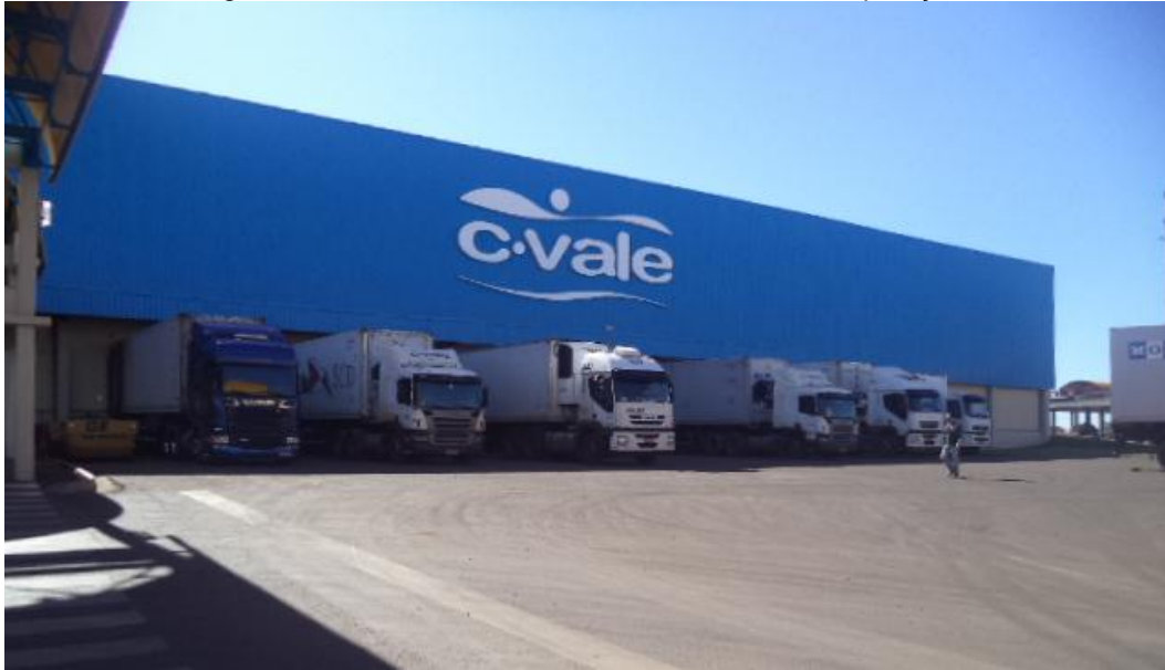
Figura 7 - Caminhões encostados nas docas de expedição.
